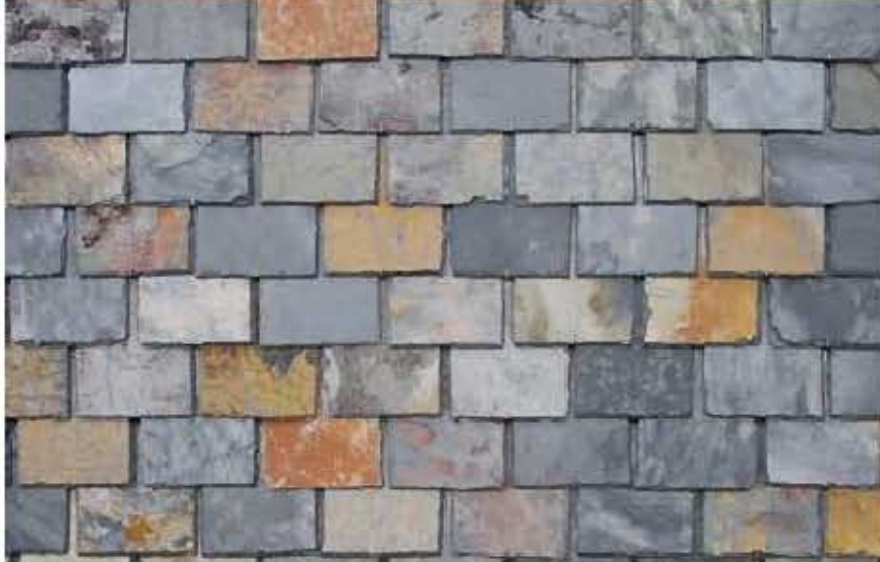
dak: natuursteen leien
