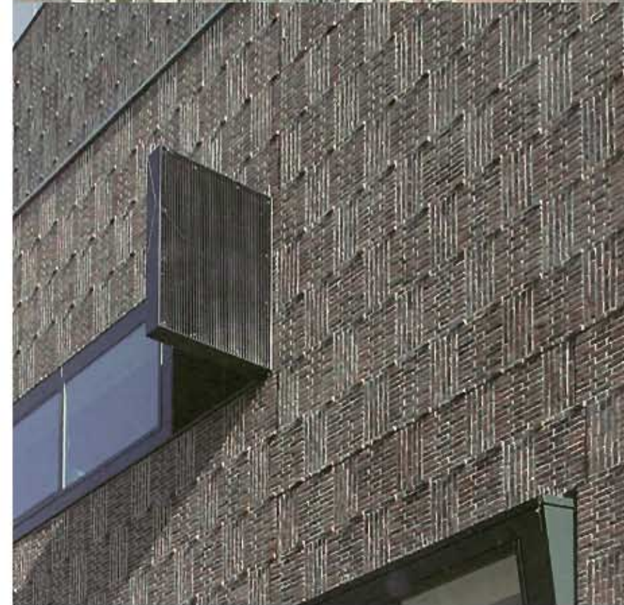
gevelvulling: metselwerk als vlechtwerk
